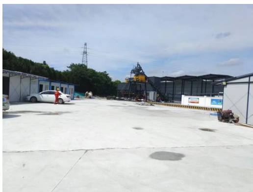
施工临时设施场地硬化
